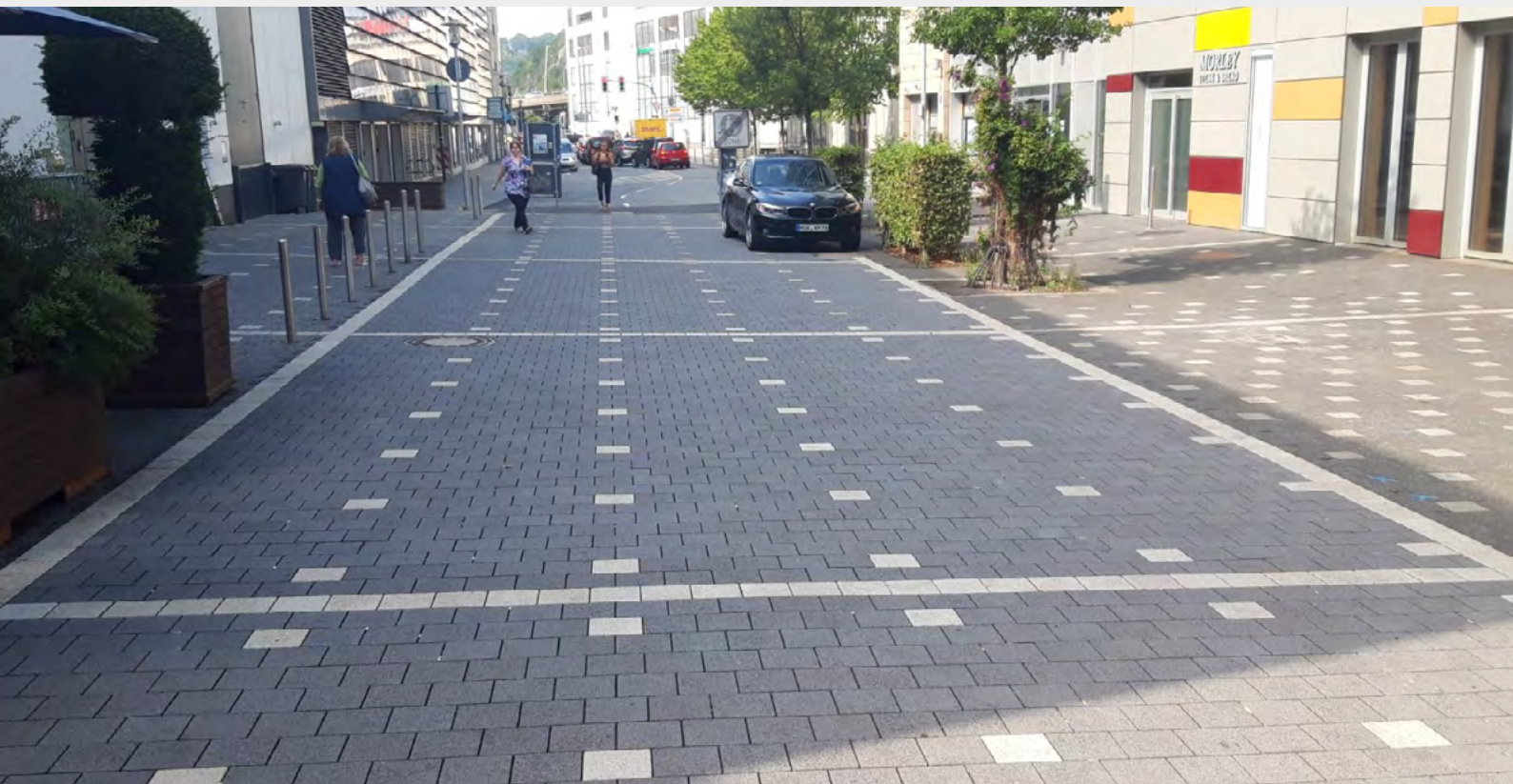
Cheops Pflastersteine in Kombination mit dem ECOPREC® Bauverfahren waren eine gute und zeitsparende Lösung für die Sanierung der Siegener Fußgängerzone. (Bild: Stadt Siegen)
